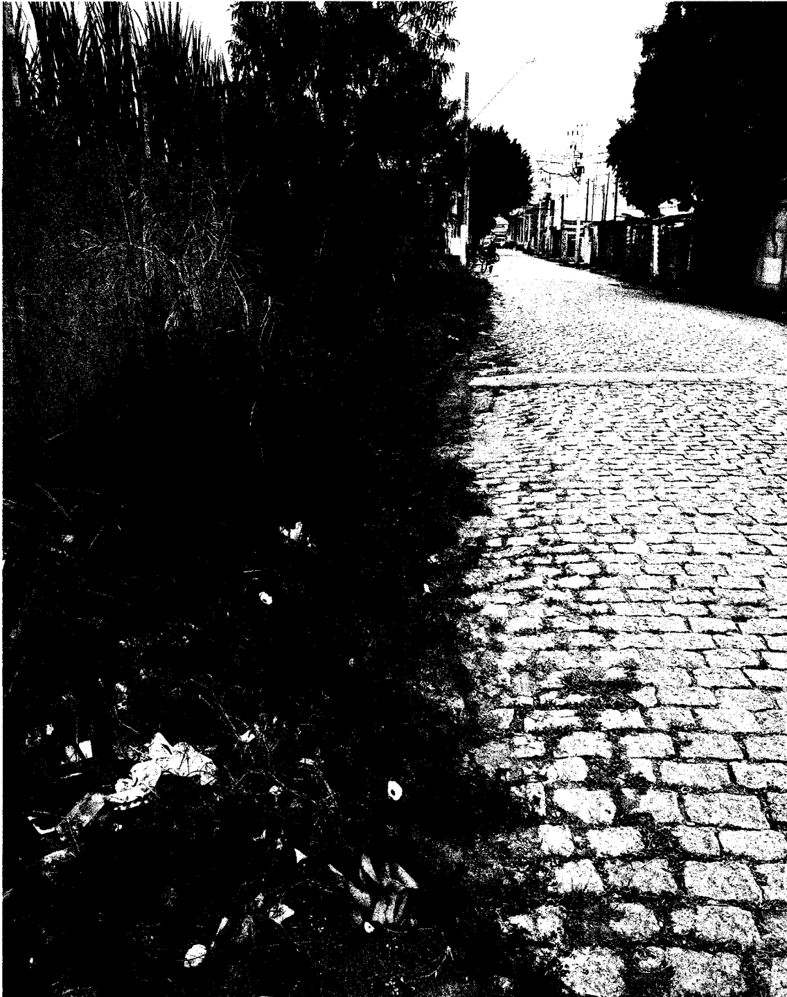
CAPINAÇÃO DE CABEÇAS DE GUIAS E RASPAGEM DE SARJETA EM TODA A EXTENSÃO DA RUA EQUADOR, JUNDIAPEBA – MOGI DAS CRUZES.
